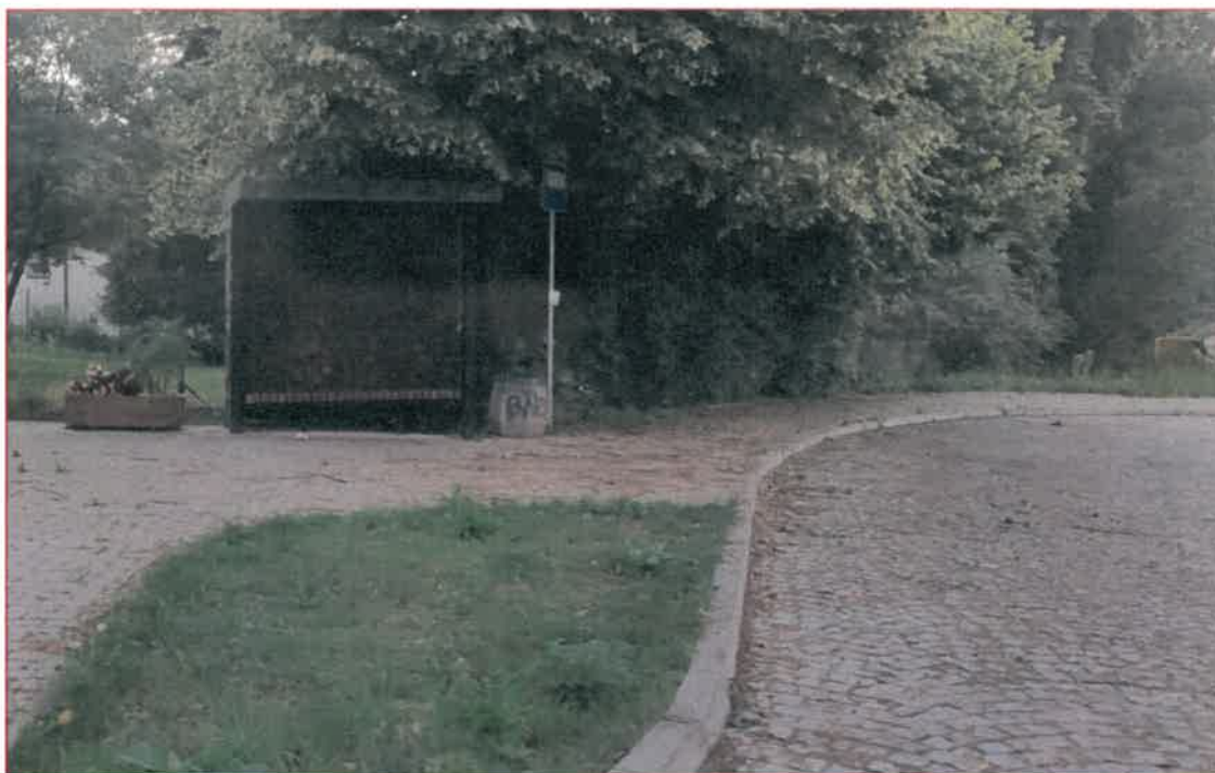
Rysunek 7.7 Inny przykład infrastruktury punktowej wymagającej modernizacji
