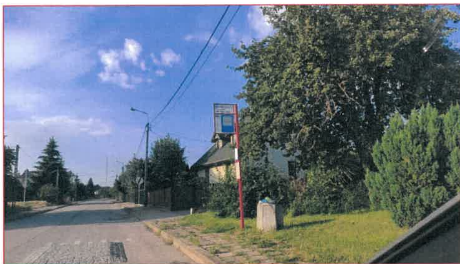
Rysunek 7.4 Przykład infrastruktury przystankowej, która wymaga modernizacji
