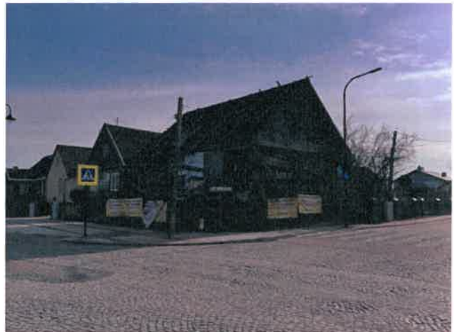
Rysunek 23. Brak ładu przestrzennego, zdegradowany obiekt mieszkalny (pustostan).
