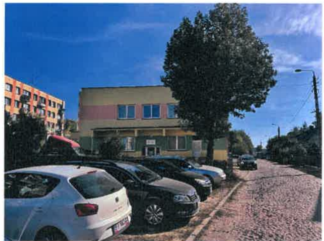
Rysunek 21. Budynek świetlicy osiedlowej – niedostosowany do potrzeb osób z niepełnosprawnościami.
